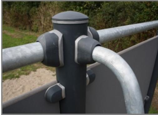
I connettori sono realizzati in alluminio pressofuso, appositamente legati per gli ambienti esterni e l'uso intenso. Le viti che fissano i connettori sono in acciaio inossidabile e protette da rondelle di zinco.
