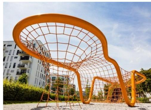
La surface de ces tubes incurvés en acier est recouverte d'une couche de peinture primaire, puis d'une couche de finition sans plomb. La peinture possède une excellente résistance à la corrosion et peut être facilement entretenue.
