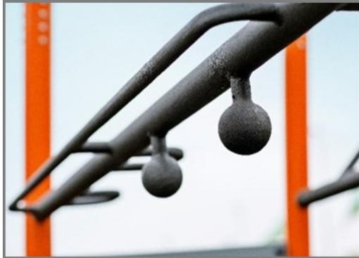
Die Polyurea-Beschichtung, die bei allen Griffen verwendet wird, ist sehr widerstandsfähig gegen Abnutzung, isoliert und bietet dem Benutzer gleichzeitig einen hervorragenden Halt während des Trainings.
