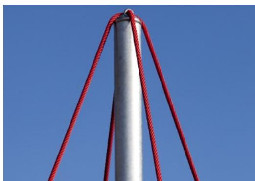
Střed síť je podepřen stožárem, vyrobeným z vysoko kvalitní bezešvé ocele. Konstrukce stožáru jako volné podpěry je staticky výhodná a vyrovňává oscilaci celé sítě. Stožáry jsou standardně pozinkovány v horké lázni a na přání mohou být povrchově upraveny práškovou barvou.
