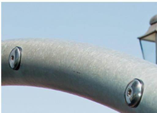
钢结构的内部和外部均使用无铅热浸镀锌。镀锌在外部环境中具有出色的耐腐蚀性，并且维护成本低。
