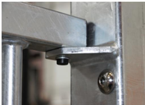
Alle Stahl Komponenten werden aus Karbonstahl gefertigt, geschweisst nach EN ISO 5817 und feuerverzinkt nach ISO 1461. Dieser Prozess gewährleistet eine lange Lebensdauer in allen Umgebungen.
