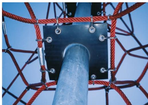
Membrány Corocord jsou vyrobeny z oděruvzdorného pogumovaného materiálu v kvalitě používané u pásových přepravníků a mají vynikající odolnost vůči UV záření. Jsou testovány a splňují nařízení REACH pro polycylické aromatické uhlvodíkyl (PAH). Je do nich integrováno čtyřvrstvé využití ze tkaného polyesteru. S tímto využitím a dvěma povrchovými vrstvami mají celkovou tloušťku 7,5 mm.
