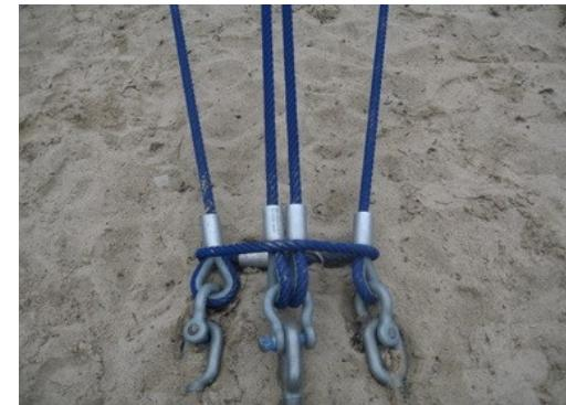
Obrovské struktury prostorových sítí jsou k základu připevněny systémem tří napínáků. Svislá a vodorovná lana jsou připevněny k jednotlivým napínákům, které se pak připojují k jednotlivým ocelovým kotvám. Tento systém zajišťuje, že každé lano může být napnuto samostatně, a zvyšuje tak bezpečnost struktury díky nezávislému kotvení.
