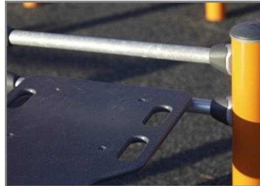
Die Oberfläche besteht aus Ekogrip™ Platten, die aus 15 mm Polyethylen mit einer 3 mm dicken Deckschicht aus thermoplastischem Gummi bestehen. Die Ekogrip™ Platten haben einen rutschfesten Effekt für komfortables und sicheres Training bei allen Wetterbedingungen.
