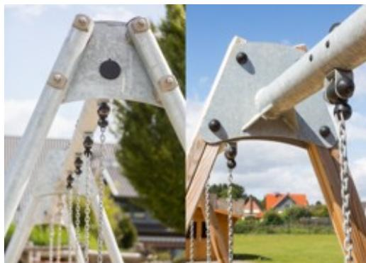
Der A-Rahmen ist mit einem feuerverzinkten Querbalken (Durchmesser 100 mm) mit Endplatten an die beiden Pfosten montiert: Feuerverzinkter Stahl (Durchmesser 70 mm). Imprägniertes Kiefernholz mit feuerverzinkten Stahlfüßen.
