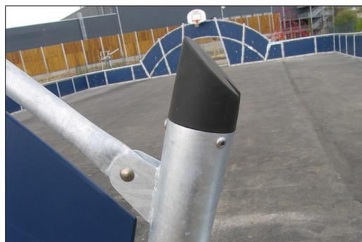
Le sommet des poteaux est moulé en caoutchouc thermoplastique (TPV) avec une incrustation en acier. Le TPV est très résistant à l'usure et à la déchirure, et l'incrustation en acier garantit la durabilité.
