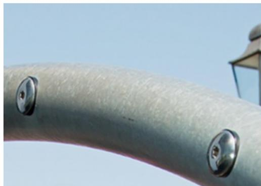
La estructura de acero está galvanizada en caliente por dentro y por fuera con zinc sin plomo. La galvanización tiene una excelente resistencia a la corrosión en ambientes exteriores y requiere poco mantenimiento.
