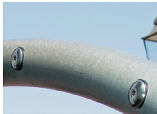
Die Stahlstruktur ist vollständig feuerverzinkt und bleifrei. Die Verzinkung sorgt für eine ausgezeichnete Korrosionsbeständigkeit in allen Außenumgebungen und macht diese wartungsarm.
