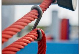
Die Corocord-S-Klemmen werden als universale Verbindungselemente für Corocord Produkte eingesetzt. 8 mm Stangen aus rostfreiem Edelstahl, mit abgerundeten Kanten werden mit einem hydraulischen Spezialwerkzeug auf die Seile gepresst und sind damit ideale Verbindungselemente: sicher, langlebig und vandalismusresistent, ohne dabei die typischen Bewegungen von Seilspielgeräten
