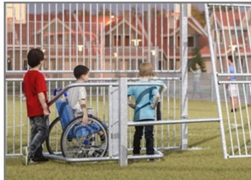
Der Rollstuhleingang besteht aus einem 80 x 80 x 3 mm Pfosten mit einem Ø 48 mm Rohr und 2 Scharnieren aus 16 mm Edelstahl. Die Öffnung ist 95cm breit und 112cm lang, was Rollstuhlfahrern den Zugang zum MUGA ermöglicht, aber Mopeds und Motorräder stoppt.
