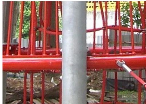
Die Metallteile sind aus hochwertigem Stahl gefertigt, innen und aussen mit bleifreiem Zink feuerverzinkt. Auf der Aussenseite befindet sich zusätzliche eine Pulverbeschichtung. Dies gewährleistet sowohl eine ausgezeichnete Korrosionsbeständigkeit als auch einen farbenfrohen Designausdruck.
