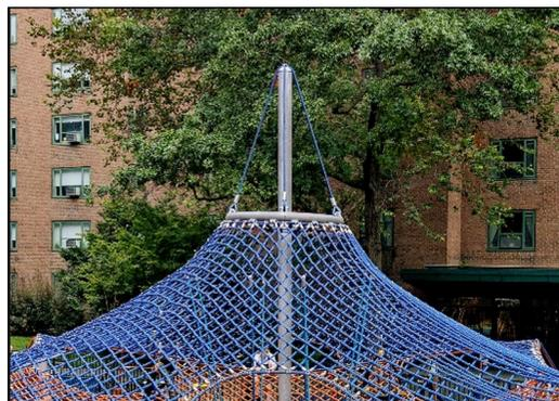
En el centro de la red está el mástil, hecho de acero sin costura de alta calidad. La estructura del mástil como soporte oscilante es estáticamente favorable e iguala las oscilaciones en la red. Los mástiles están galvanizados en caliente de serie, con la opción de diseño de recubrimiento en polvo adicional.
