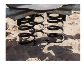
KOMPAN 弹簧由符合 EN10270 的优质弹簧钢制成。弹簧通过磷化处理进行清洁,然后将其涂上环氧底漆和聚酯粉末涂料作为上光油。弹簧通过独特的防夹配件固定,以实现最大的安全性和较长的使用寿命。
