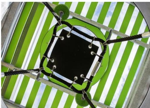
Le membrane Corocord sono realizzate in materiale gommatto antifrizione della qualità del nastro trasportatore con eccellente resistenza ai raggi UV. Testato e conforme ai requisiti REACH per PAH. Embedded è un rivestimento a quattro strati realizzato in poliestere intrecciato. L'armatura e i due strati superficiali producono uno spessore totale di 7,5 mm.
