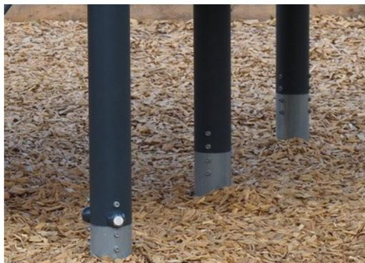
Les poteaux principaux avec le pied en acier galvanisé à chaud sont disponibles en différents matériaux : Poteaux en bois de pin imprégnés sous pression, poteaux en acier prégalvanisé à l'intérieur et à l'extérieur avec une finition de surface thermolaquée, poteaux en aluminium sans plomb avec couleur anodisée en finition de surface.
