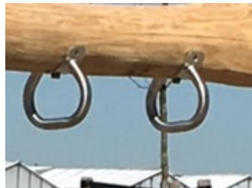
Le maniglie per arrampicata sospese sono realizzate in acciaio inossidabile di alta qualità. Le maniglie sono fissate alla traversa superiore in robinia mediante bulloneria in acciaio inossidabile.
