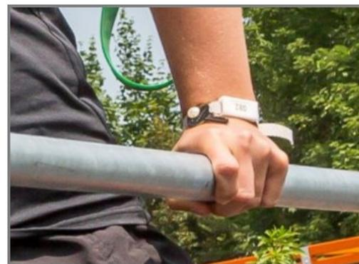
Die für die Übungen vorgesehenen Stangen sind aus feuerverzinktem Stahl mit einem Durchmesser von 48 mm gefertigt. Der Durchmesser dieser Stangen bietet eine gute Stütze bei Liegestützübungen.
