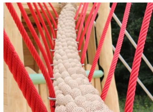
Die Corocord-Seile an der Brücke werden mit der Hercules-Technik gefertigt und bestehen aus verzinkten, sechslitzigen Stahldrahtseilen, die mit einem Stahlkern versehen sind. Das PP-Seil in Kokostau-Optik hat einen Durchmesser von 15 cm. Der Stahldrahtseilkern hat Kauschen an beiden Enden, welche der Befestigung der Seile an die vorhandenen Verbindungselementen dienen.
