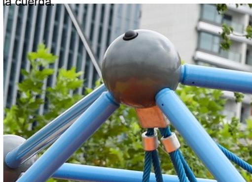
Las partes metálicas están hechas de acero de alta calidad, galvanizado en caliente por dentro y por fuera con zinc sin plomo. En el exterior, hay una capa adicional de recubrimiento en polvo. Esto garantiza una excelente resistencia a la corrosión y una expresión de diseño colorida.
